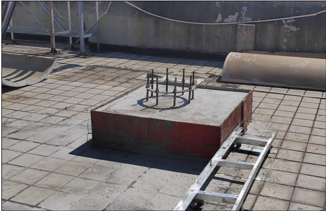
图 3-3 本项目拟浇筑的 1m×1m 混凝土天线基础
