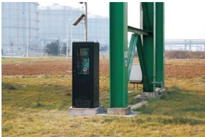
◎ 在河北，为钢铁公司厂区安装污水计量监测设备
